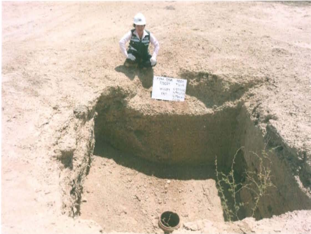
Fotografía N° 1. Identificación del pozo inactivo con código PERUPETRO T3649. Presenta casing abierto y corroido en el interior de una excavación.
