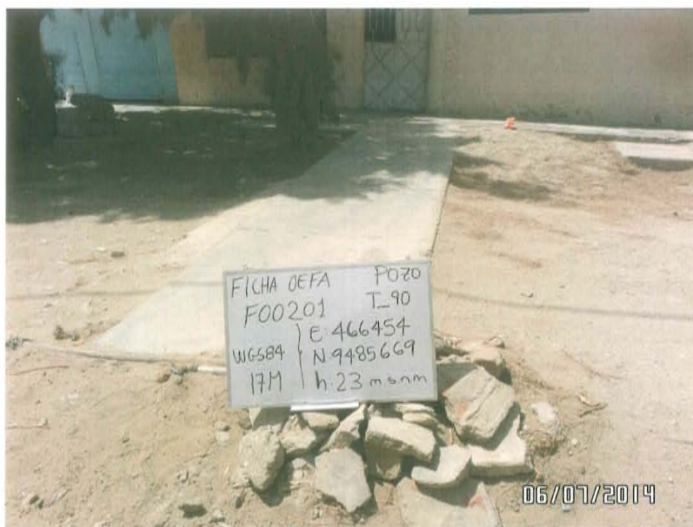
Fotografía N° 1. El Pozo T_90, se ubicaría en este punto, donde se visualiza conexiones de tuberías, las cuales se encuentran frente a una vivienda de la localidad de Negritos.
