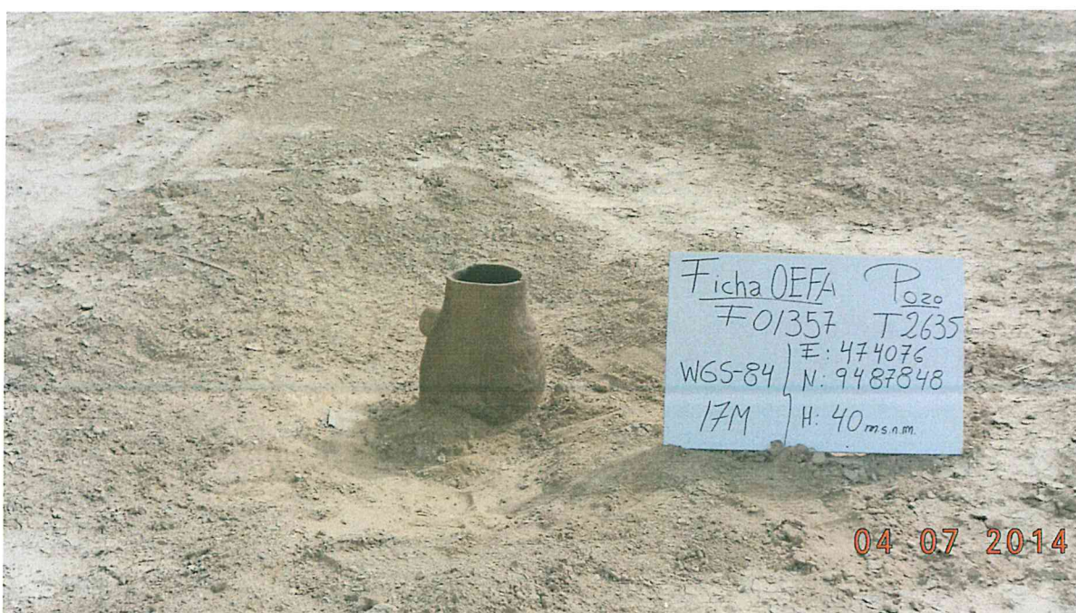
Fotografía N° 2. Pozo abierto y expuesto al ambiente sin accesorios que aseguren su hermetismo, con casing que sobresale 0,31 m sobre la superficie del suelo.
