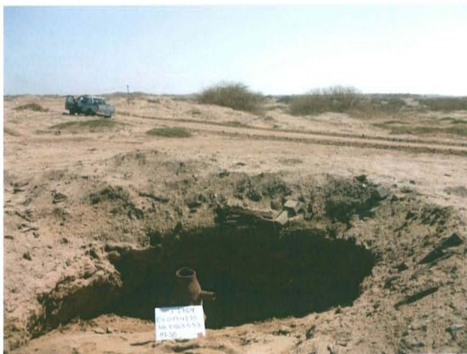
Fotografía N° 2. El pozo presenta tubo deteriorado abierto de 5,7 pulgadas de diámetro, cortado y corroído expuesto 0,72 m sobre la superficie del terreno.
