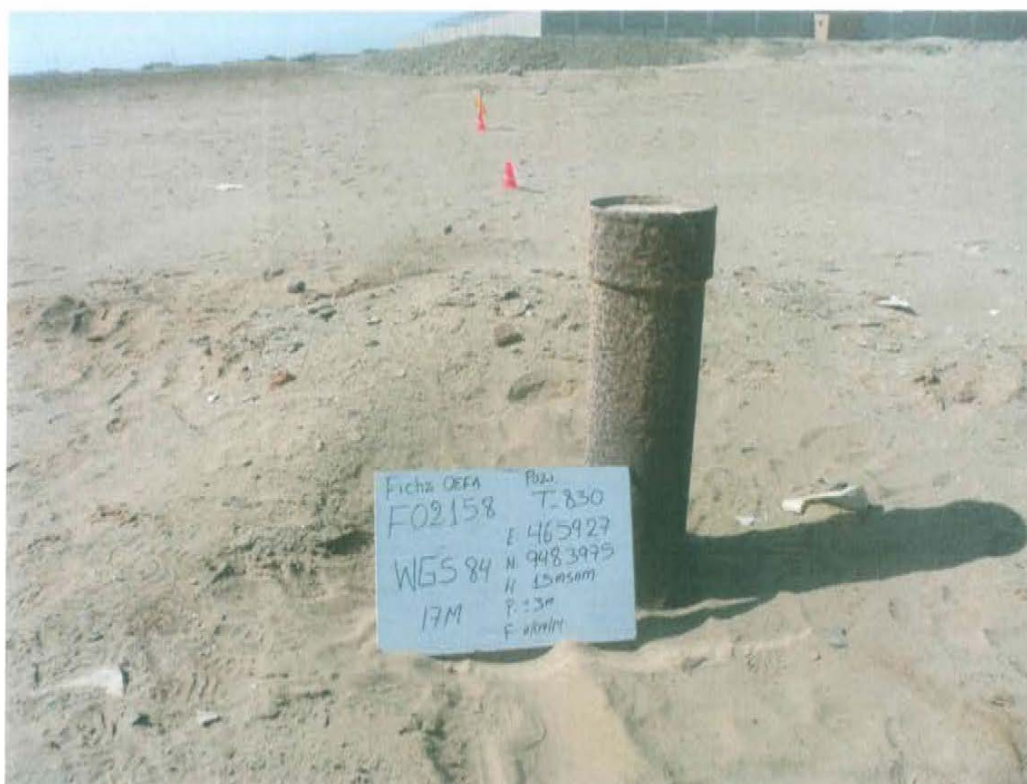
Fotografía N° 1. Se observa casing corroído que sobresale 1 m del nivel de la superficie del suelo.
