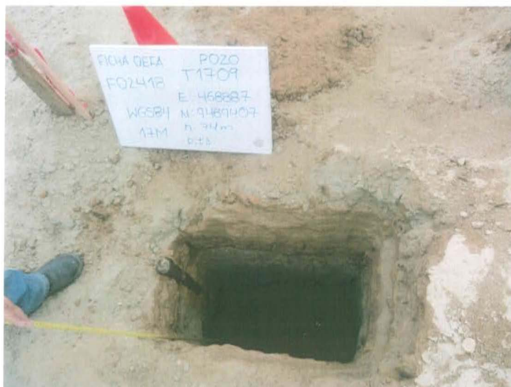
Fotografía N° 1. Identificación del pozo inactivo con código PERUPETRO T1709. Presenta tubería metálica corroida descubierta en el interior de una excavación de sección rectangular.
