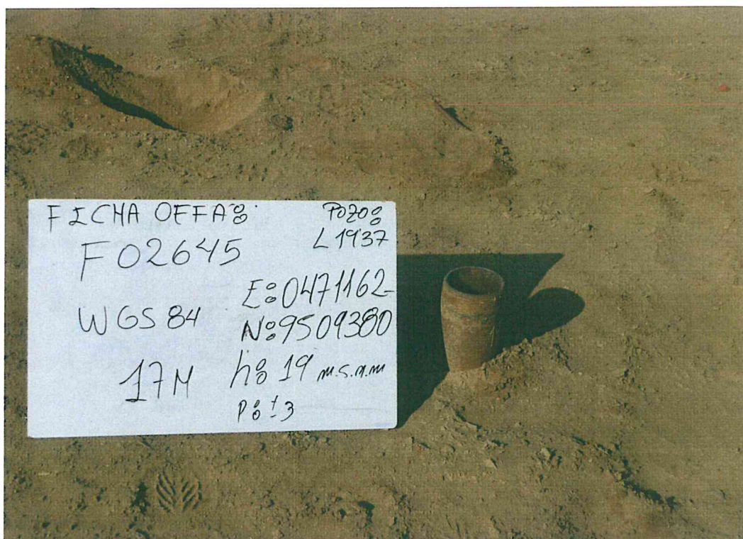
Fotografía N° 1. Pozo inactivo en terreno no habilitado, sin cabezal, presenta casing (tubería de producción) de 5 plg de diámetro, que sobresale en 0,15 m sobre el nivel del suelo.
