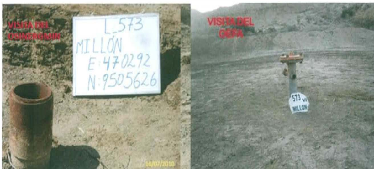
Fotografía N° 2. Pozo L_573 modificado en relación a la ficha de registro de OSINERGMIN del 2010, al agregarle la brida y válvula de reducción.
