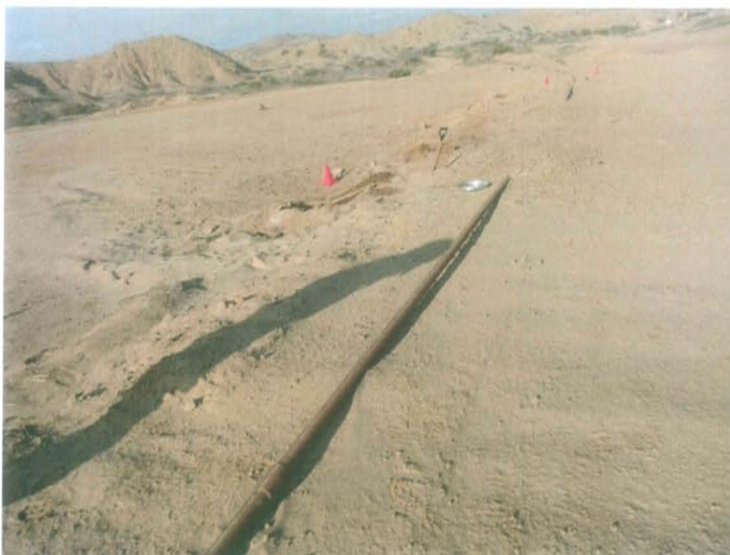
Fotografía N° 3. Se observa una tubería perteneciente a actividades de extracción de hidrocarburos que pasa muy cerca de la posible ubicación del pozo.
