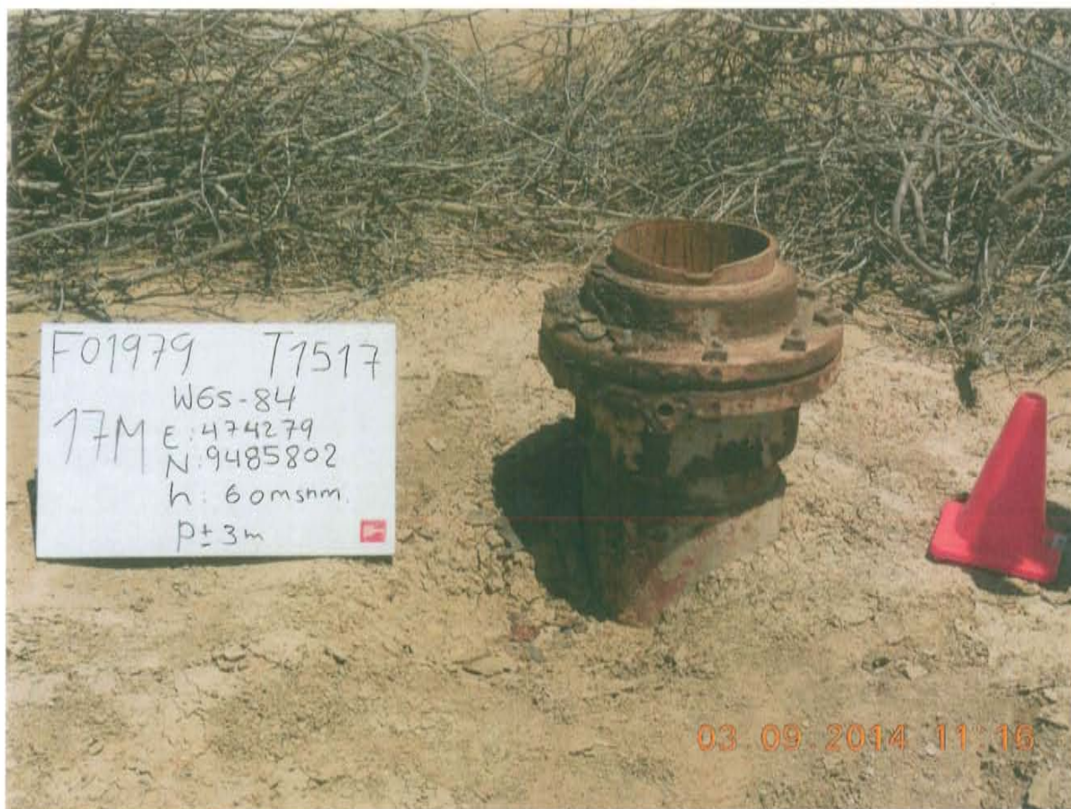
Fotografía N° 1. Pozo inactivo sin terraplén habilitado, se observa casing y brida corroido, sin ningún elemento de cierre hemético, por lo que se encuentra abierto y expuesto al ambiente.
