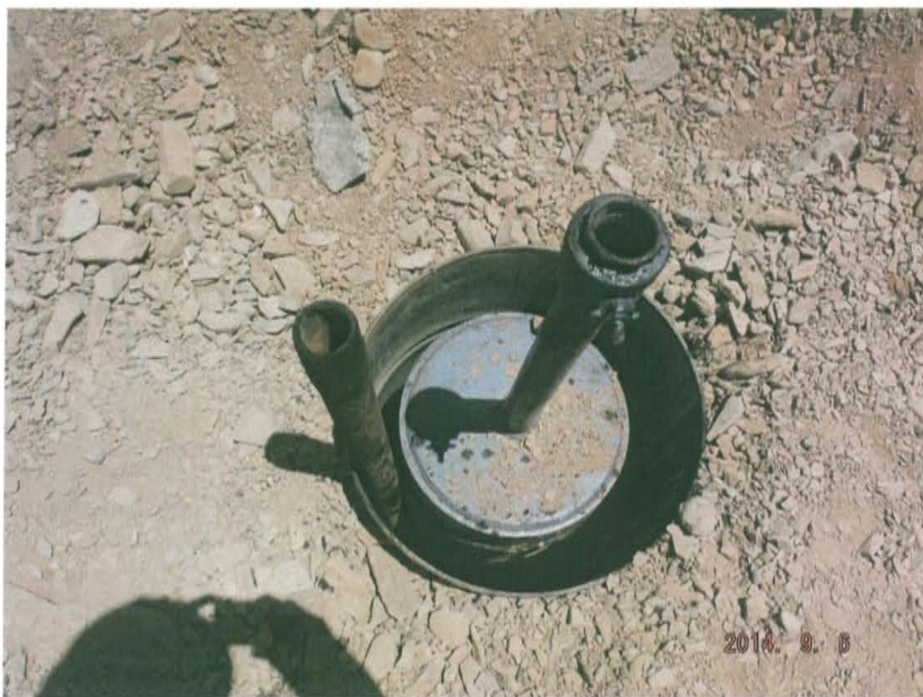
Fotografía N° 2. El pozo presenta dos tubos, uno unido al casing interior del pozo y el otro acondicionado para posible extracción artesanal por personas extrañas.
