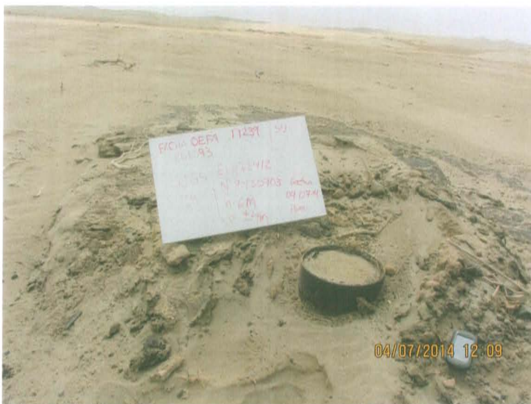
Fotografía N° 1. Se observa casing corroído que contiene arena en su interior.
