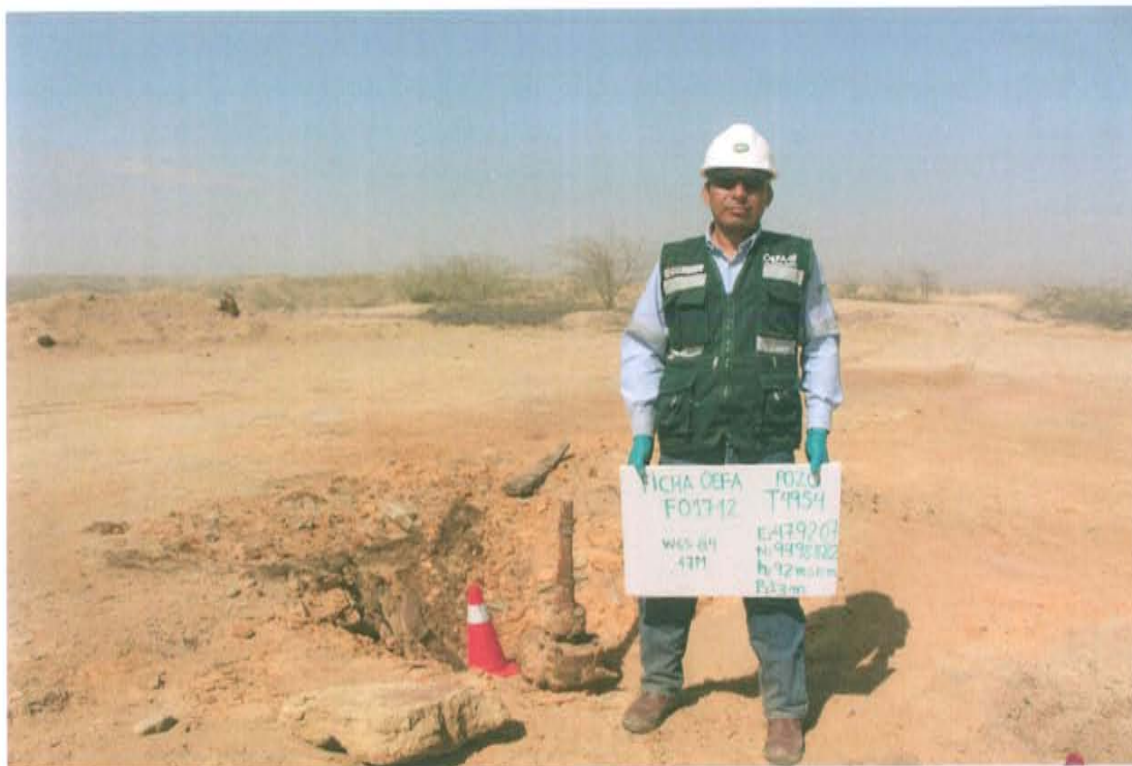
Fotografía N° 1. Identificación del pozo inactivo con código PERUPETRO T4954. Presenta casing con brida y sin válvulas en el interior de una excavación.
