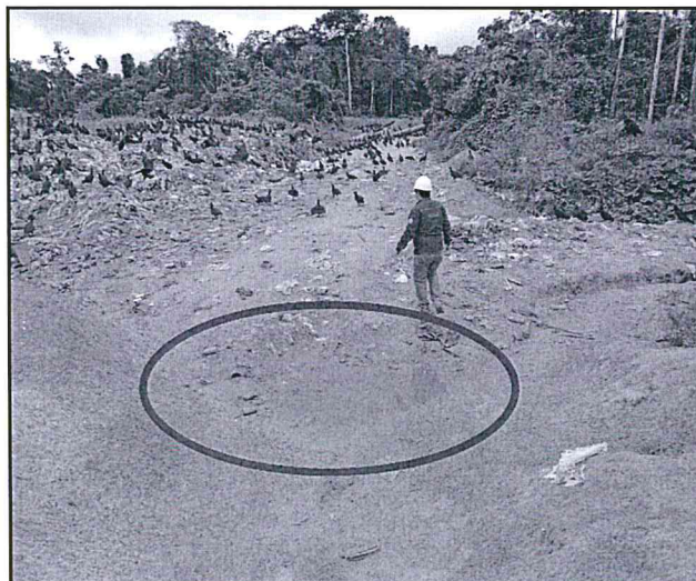
Fotografía N° 07: Canal precario por donde discurren efluentes (lixiviados)
