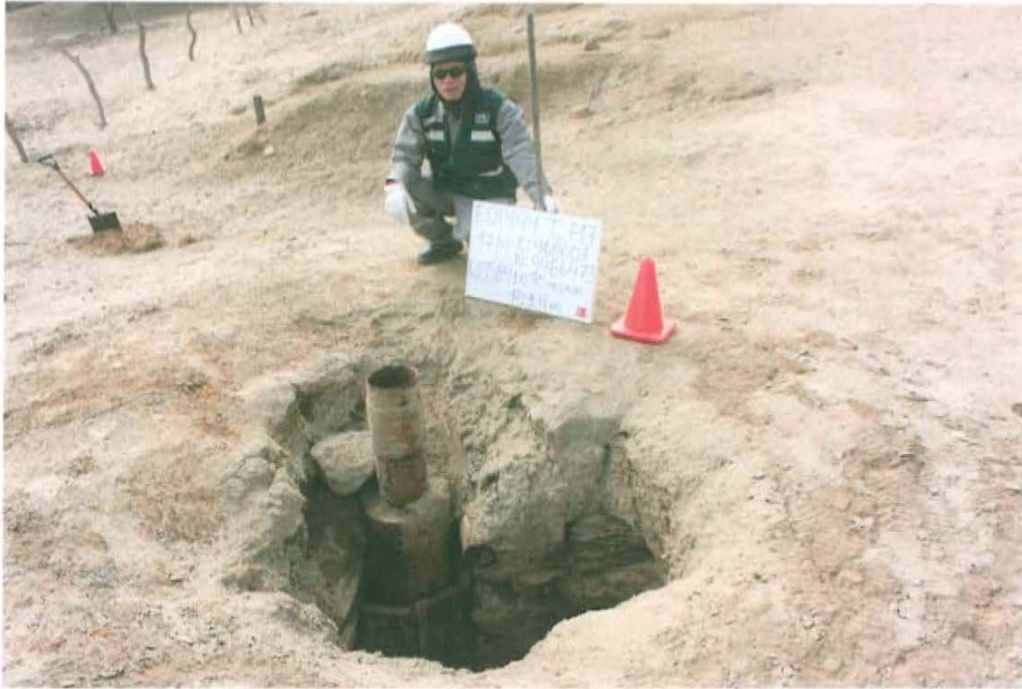
Fotografía N° 1. Pozo T_717, presenta casing de superficie y de producción dentro de un hoyo de 1,2 m de profundidad.
