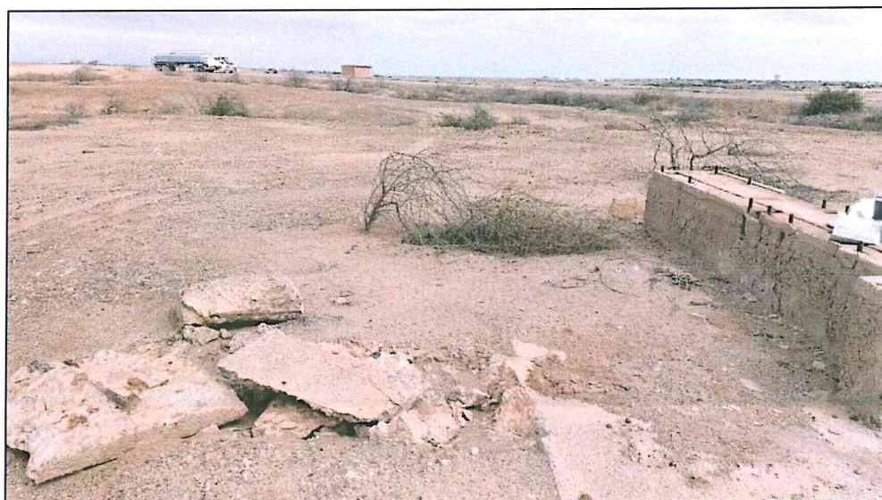
Fotografía N° 2. Ubicación de una estructura de cemento que ha sido base de la unidad de bombeo mecánico
