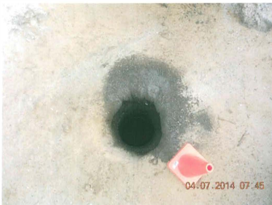
Fotografía N° 2. Se visualiza un casing de 13 plg de diámetro, ubicado a 0,14 m por debajo del nivel del suelo.
