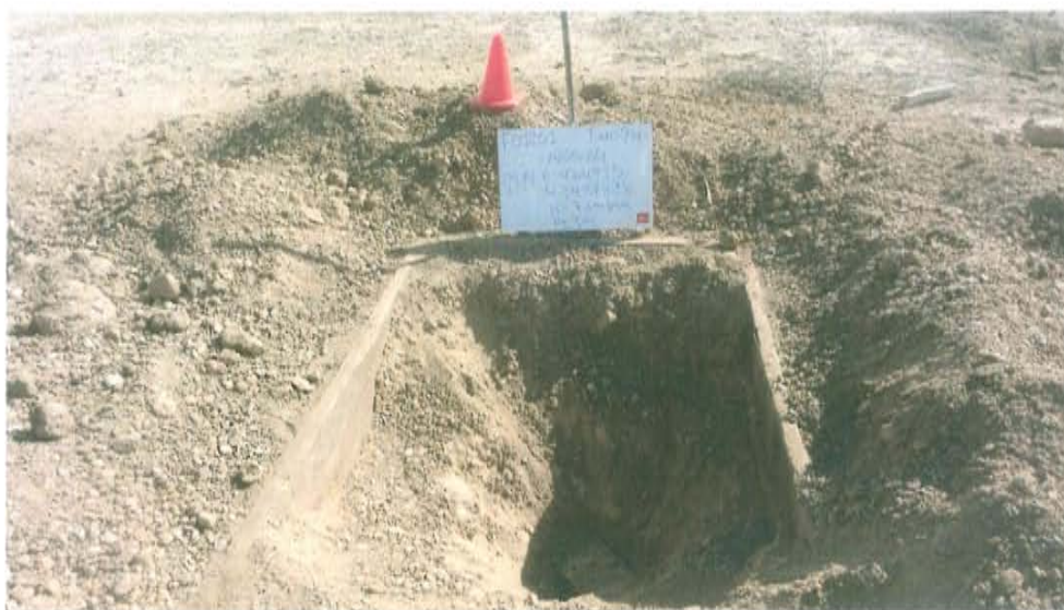
Fotografía N° 1. Vista del Pozo T4094, se encuentra al ras del suelo en un hoyo revestido con madera.
