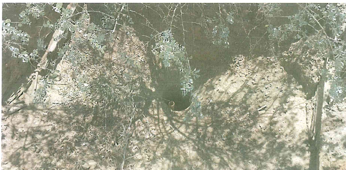
Fotografía N° 1. Pozo abandonado con código PERUPETRO T2832 y con código Ficha OEFA F00598, se observa el casing y el tubing dentro de un hoyo (posible restos de una cantina de madera), que se encuentra abiertos al ambiente.
