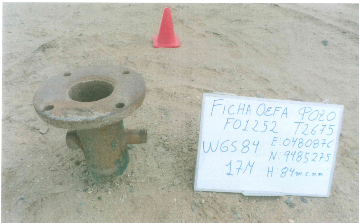
Fotografía N° 1. Pozo con código PERUPETRO T2675 y código Ficha OEFA F01252, se observa el casing con cabezal compuesto sólo por una brida sin ningún elemento de cierre por lo que se encuentra abierto al ambiente.
