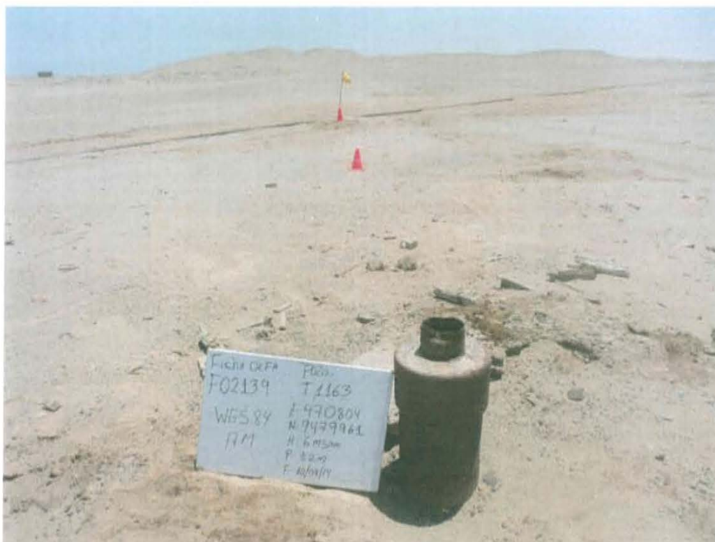
Fotografía N° 1. Se observa dos (02) casing concéntricos corroídos cementado en la sección anular y el casing interior abierto al ambiente.
