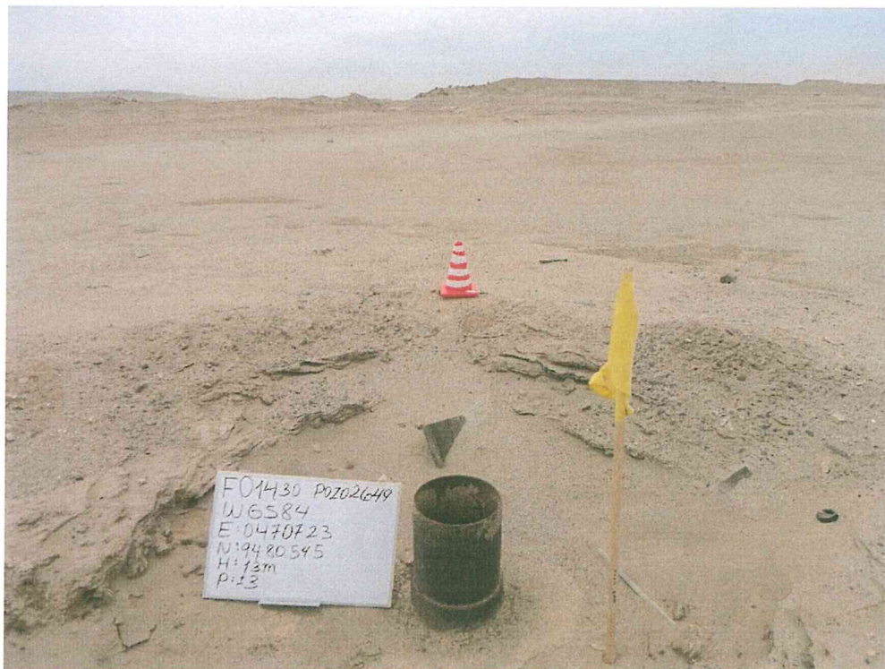
Fotografía N° 1. Pozo mal abandonado perteneciente a la ficha F01430 visiblemente corroído y sin accesorios que aseguren su hermetismo.
