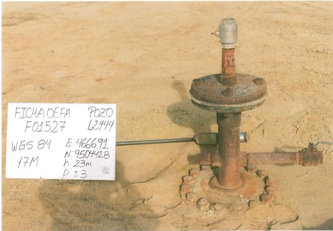
Fotografía N° 1. Identificación del pozo inactivo con código PERUPETRO L2444. Presenta casing con brida y válvula cierre lateral corroída.
