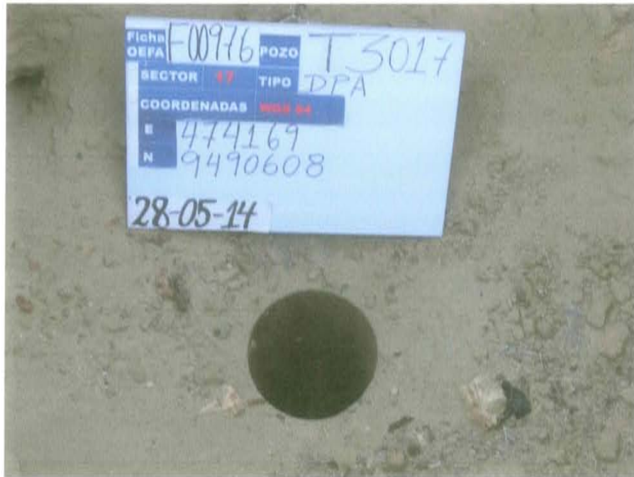
Fotografía N° 1. Pozo T3017, abierto cortado al ras de la superficie del hoyo
