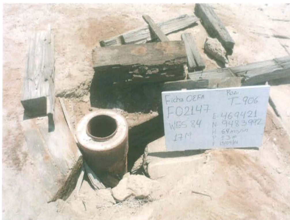
Fotografía N° 1. Identificación del pozo inactivo con código PERUPETRO T_906. Presenta dos casing concéntricos, uno de ellos cementado en la sección anular y el otro abierto, sin dispositivos de cierre y con tacones de madera alrededor.
