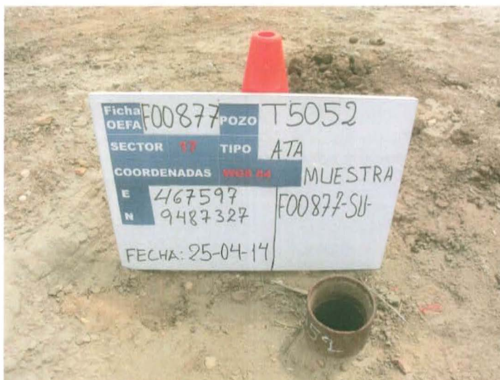
Fotografía N° 1. El Pozo T5052 presenta un casing de 5 pulgadas el cual se encuentra abierto y expuesto al ambiente.
