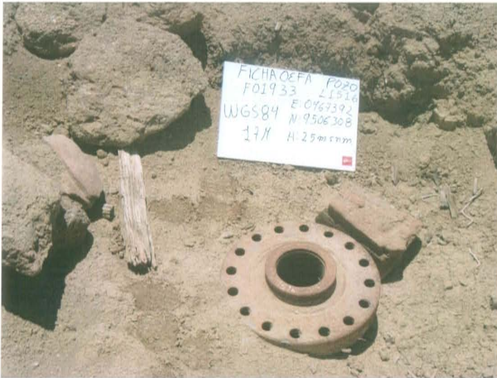
Fotografía N° 1. Identificación del pozo inactivo con código PERUPETRO L1516. Presenta casing abierto al medio ambiente.
