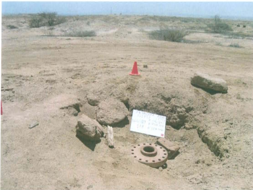
Fotografía N° 2. Vista del área circundante del pozo inactivo L1516.
