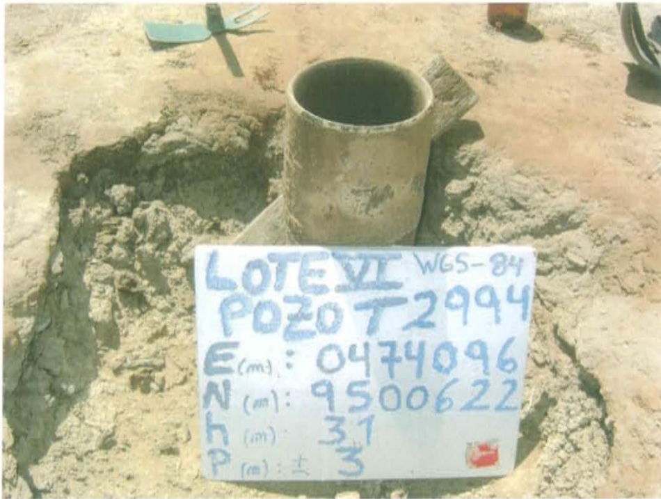
Fotografía N° 1. Se observa pozo mal abandonado con casing sin tapón y expuesto al aire libre.
