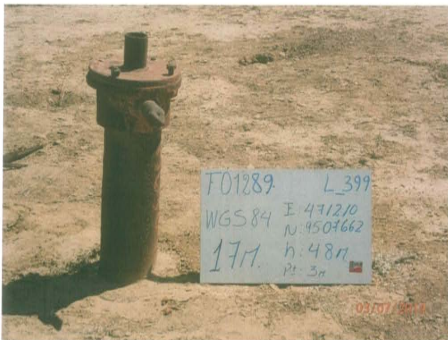
Fotografía N° 1. Vista donde se observa el pozo inactivo presenta casing con brida, tubo de reducción sin cabezal con signos de corrosión.
