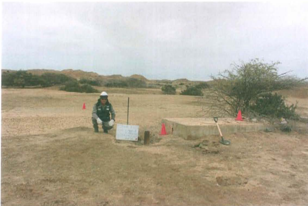
Fotografía N° 2. Se observa a 0,8 m del pozo un bloque de concreto, posible soporte del equipo de bombeo mecánico.
