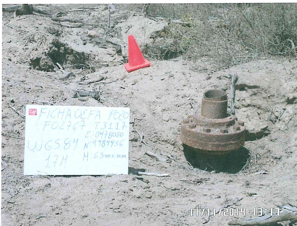
Fotografía N° 1. Se observa casing del Pozo T3117 abierto y expuesto al ambiente.
