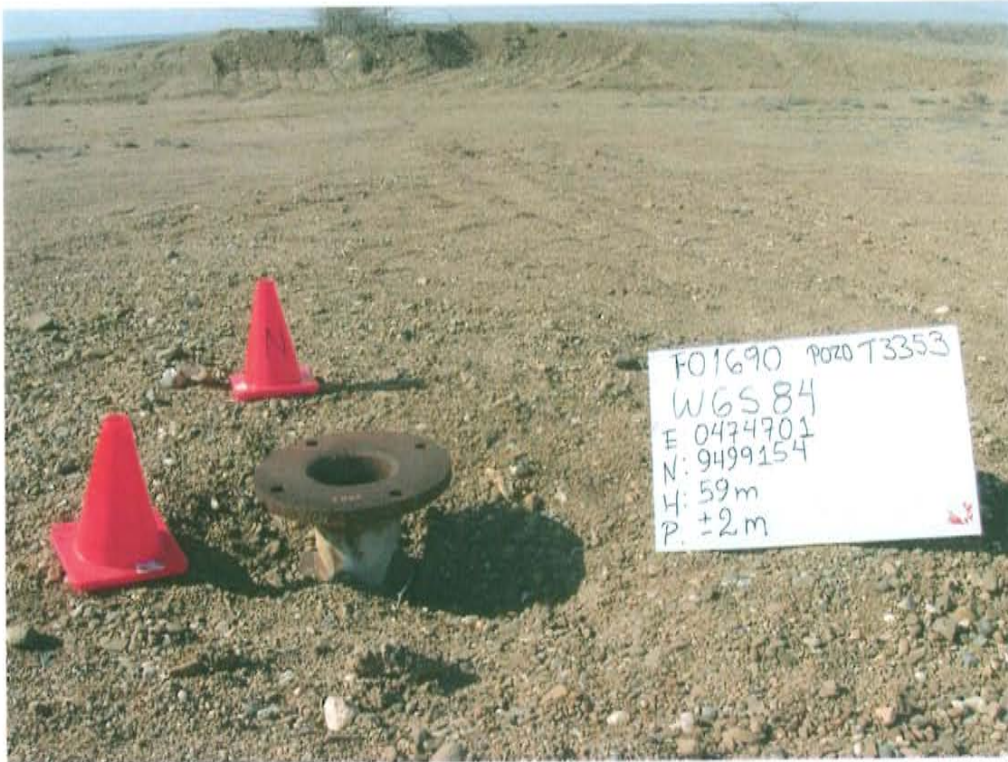
Fotografía N° 1. Identificación del pozo inactivo con código PERUPETRO T3353. Presenta casing sin válvulas que aseguren su hermetismo.
