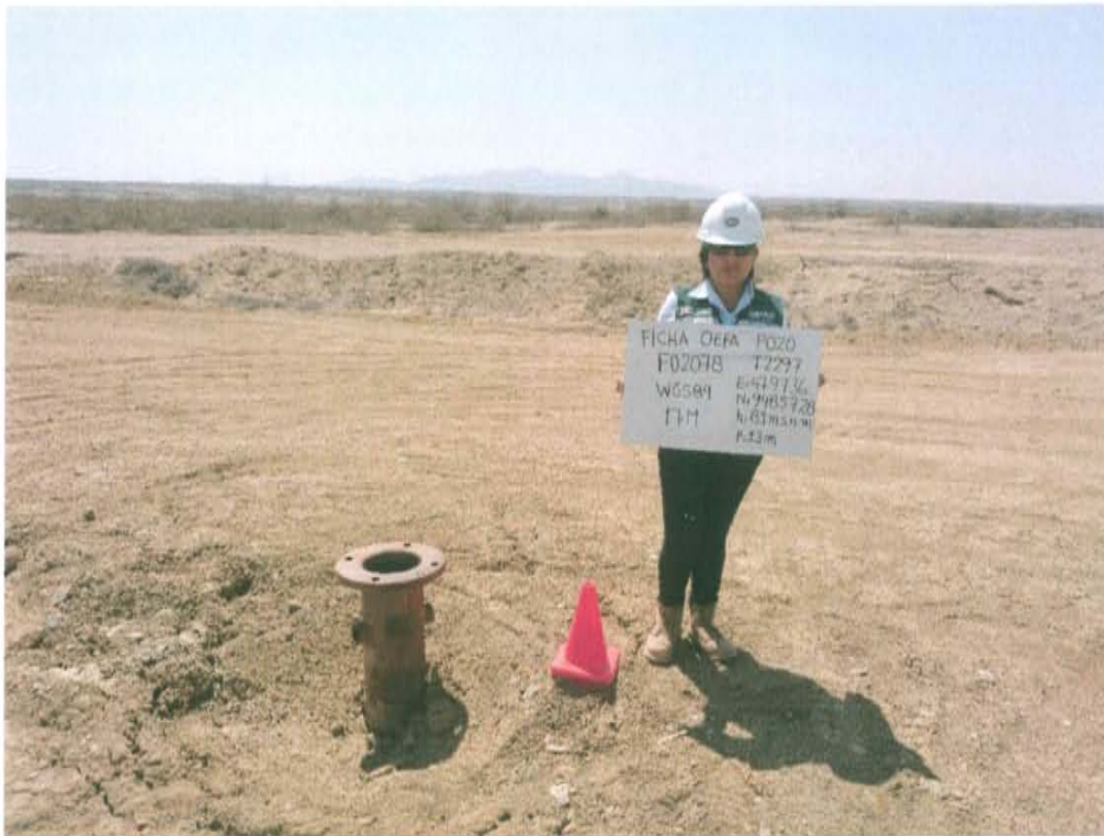
Fotografía N° 1. Identificación del pozo inactivo con código PERUPETRO T2297. Presenta casing con tapa de brida adaptadora y tubería con salidas laterales expuestas a la intemperie.
