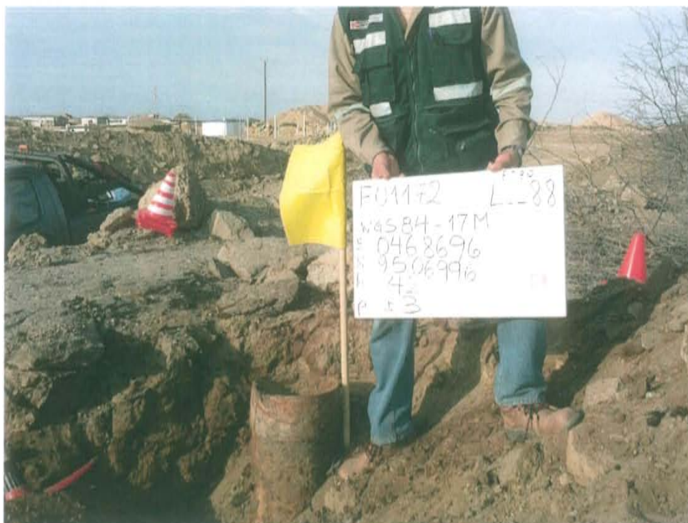
Fotografía N° 1. Identificación del pozo inactivo con código PERUPETRO L__88. Presenta casing sin elementos de cierre en la superficie.
