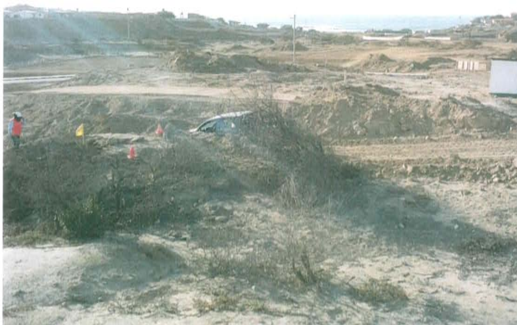
Fotografía N° 4. Se observa la nivelación del área adyacente al pozo para la lotización de terrenos para viviendas.
