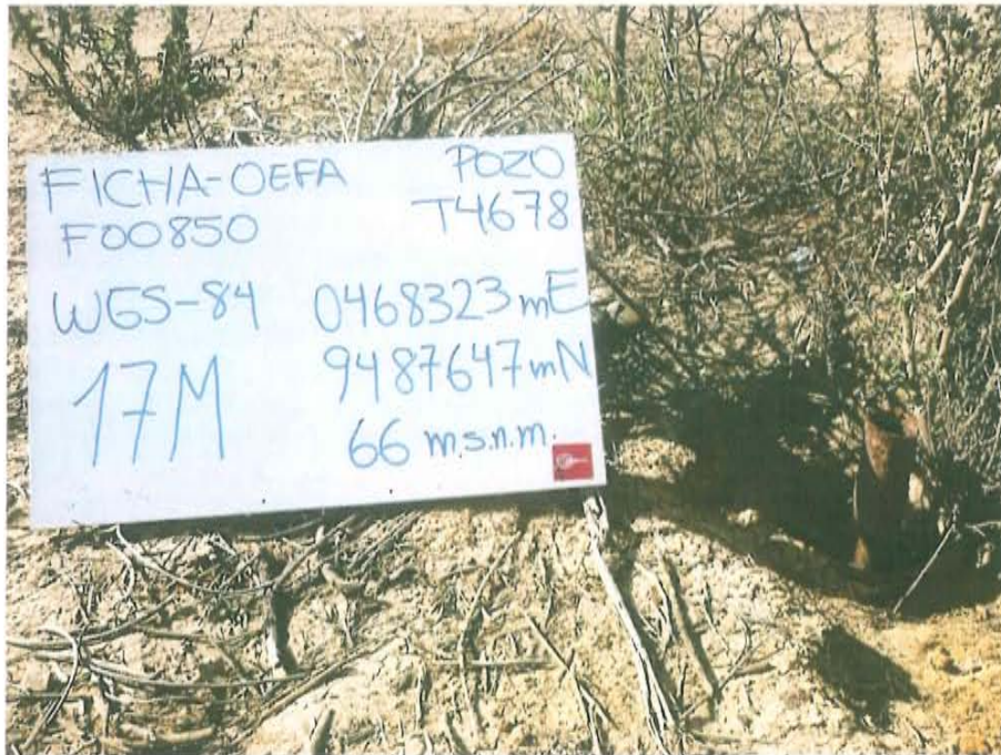
Fotografía N° 1. Se observa casing de 8 plg de diámetro y una tubería intermedia de 2 ½ plg de diámetro, abiertos sin cabezal ni accesorios que aseguren su hermetismo.
