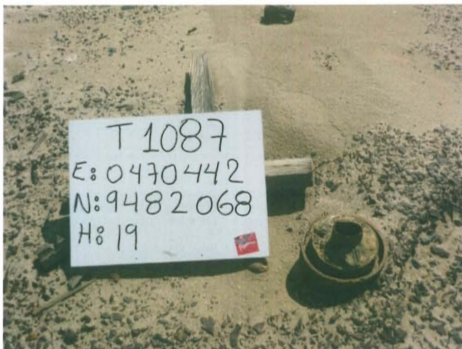
Fotografía N° 1. Vista del Pozo T1087, presenta casing cementado con tubería interior abierto que sobresale 0,08 m sobre el nivel del suelo.
