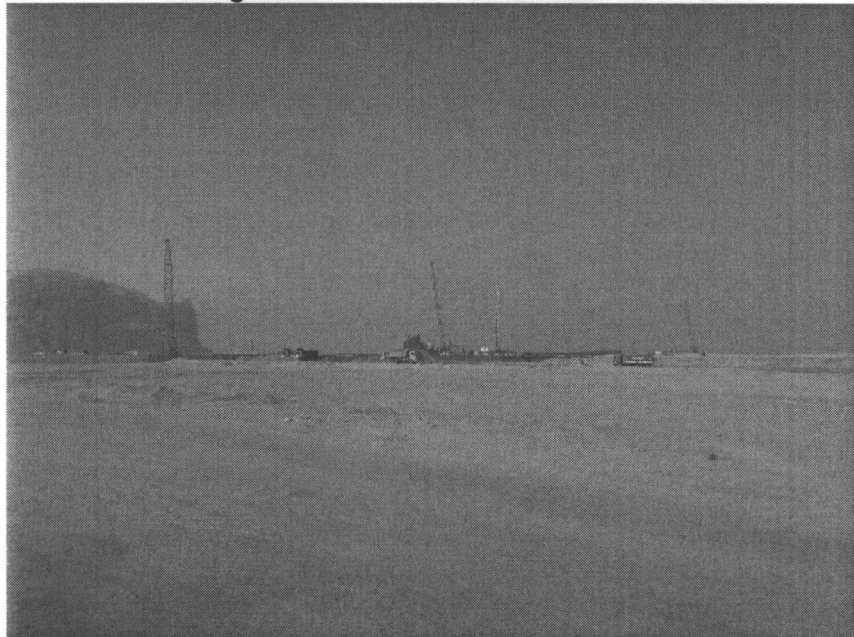
Fotografía N° 1.- Vista del Muelle en construcción.
