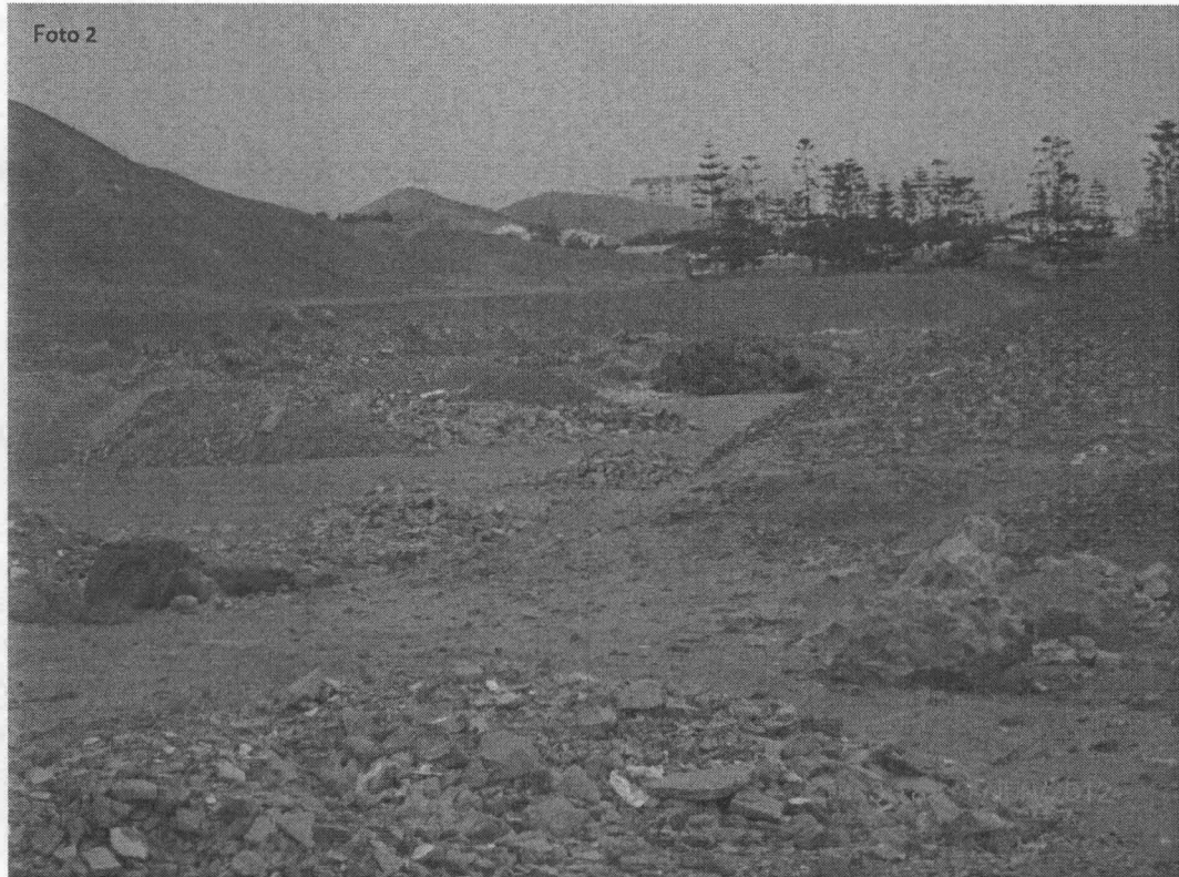
Fotografía N° 2. Vista panorámica de la magnitud del botadero de residuos, a la altura del Km 53 y 54 de la Panamericana Sur, (cerca al ingreso por la antigua Carretera Panamericana Sur al balneario de Santa María del Mar). Coordenadas UTM WGS 84 (18L 0308303E 8629186N)
