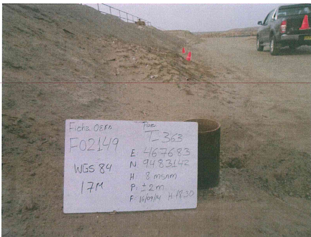
Fotografía N° 1. Se observa casing corroído, que se encuentra abierto al ambiente.
