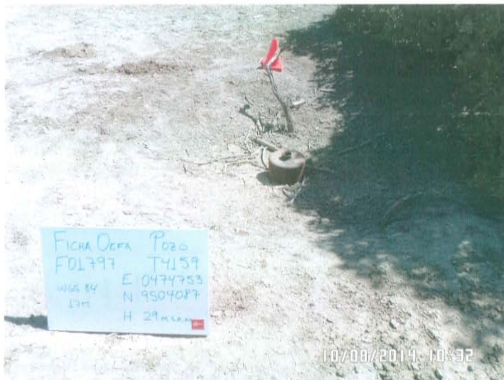
Fotografía N° 1. Identificación del pozo inactivo con código PERUPETRO T4159. Presenta casing sin válvula que no aseguraba su hermetismo.
