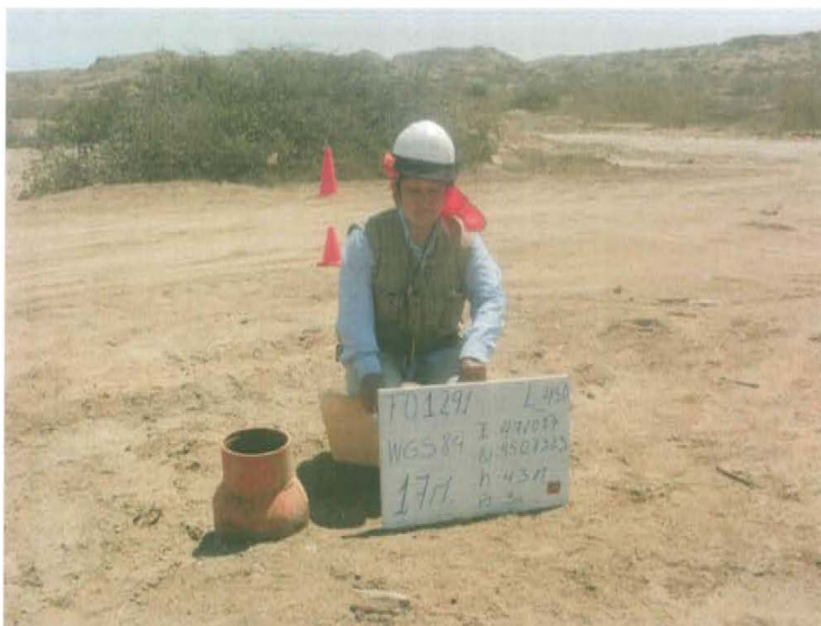
Fotografía N° 1. El casin presenta tubo de reducción abierto de 9 pulgadas y expuesto a unos 0,3 m sobre la superficie del terraplen
