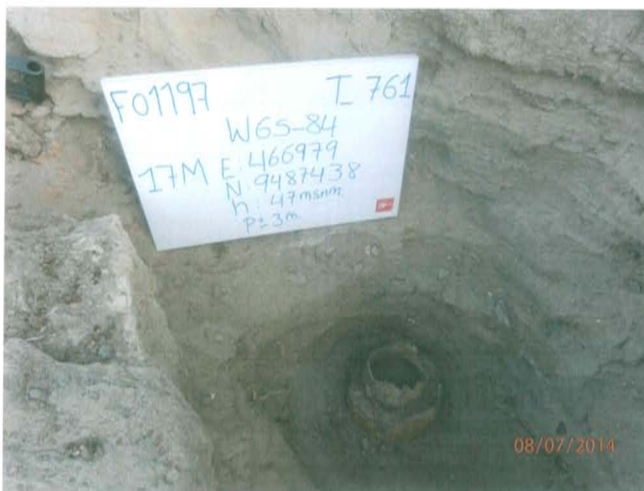
Fotografía N° 1. Pozo T_761, presenta casing de superficie y de producción cortado y abierto, dentro de un hoyo.
