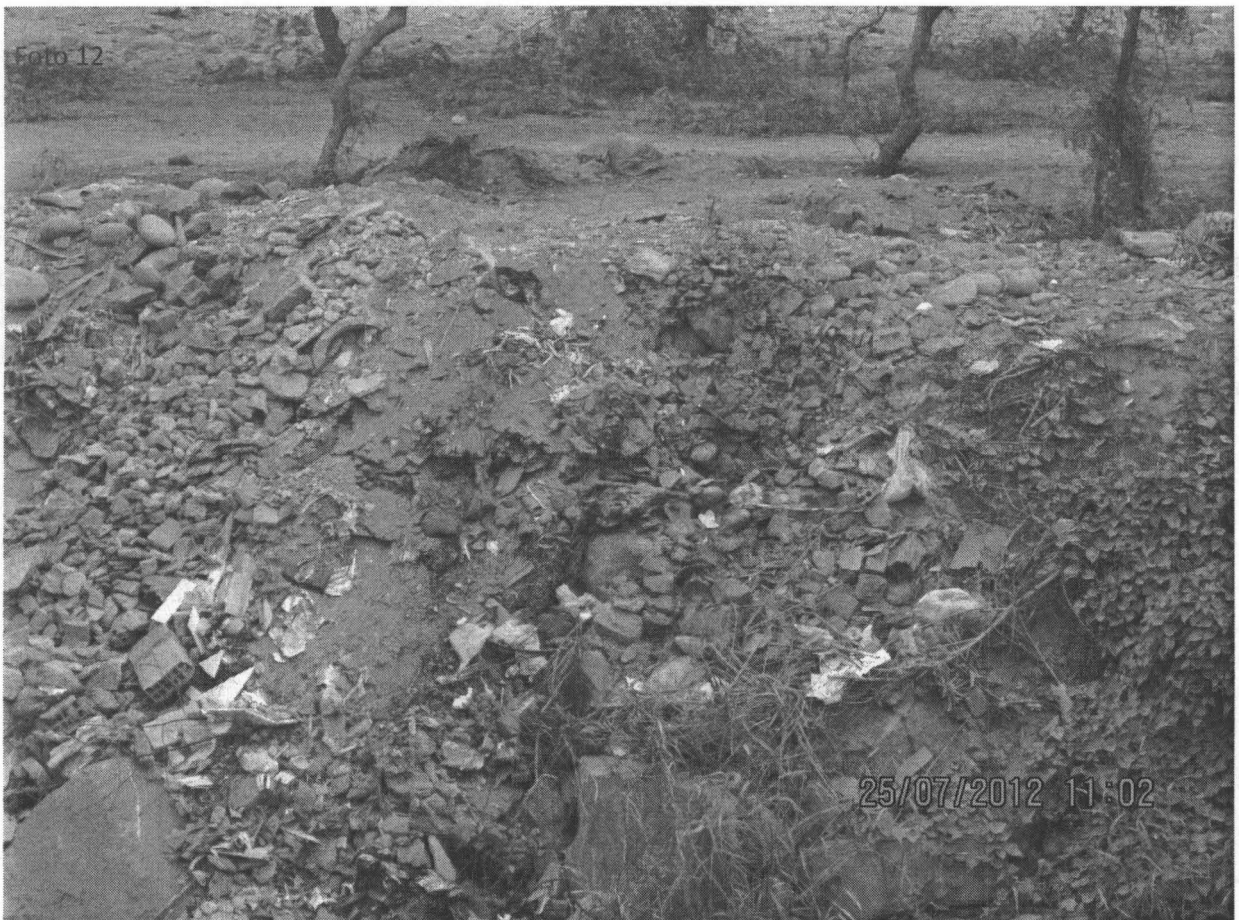
Fotografía N° 12. Evidencia de acumulación de residuos de construcción y residuos domésticos en sobre el cauce del río Chillón aguas abajo del Puente Peatonal inspeccionado, en el distrito de Los Olivos, Coordenadas UTM WGS 84 (18L 0273805E 8681056N)
