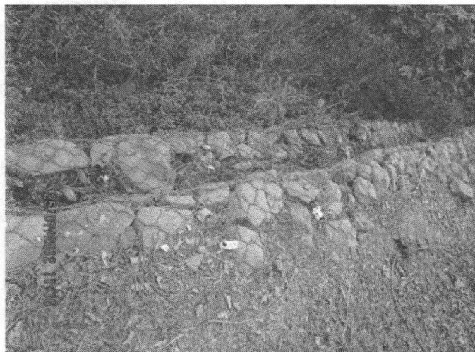
de Fotografías N° 15a y 15b. Evidencia del enmallado de los taludes de reforzamiento en el cauce del río Chillón aguas abajo y aguas arriba del punto inspeccionado en el distrito de Los Olivos, Coordenadas UTM WGS 84 (18L 0273557E 8680291N)
