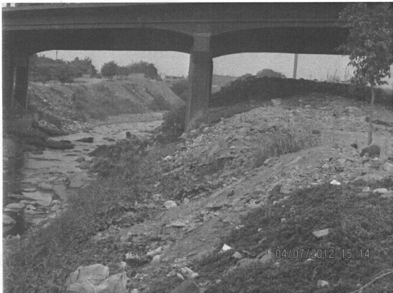
Fotografía N° 01. Vista panorámica del cauce del río Chillón en la jurisdicción del distrito de Los Olivos, a la altura del Puente Chillón cruce con la Av. Panamericana Norte. Nótese las partes bajas acumuladas de residuos Coordenadas UTM WGS 84 (18L 0274144E 8681676N)
