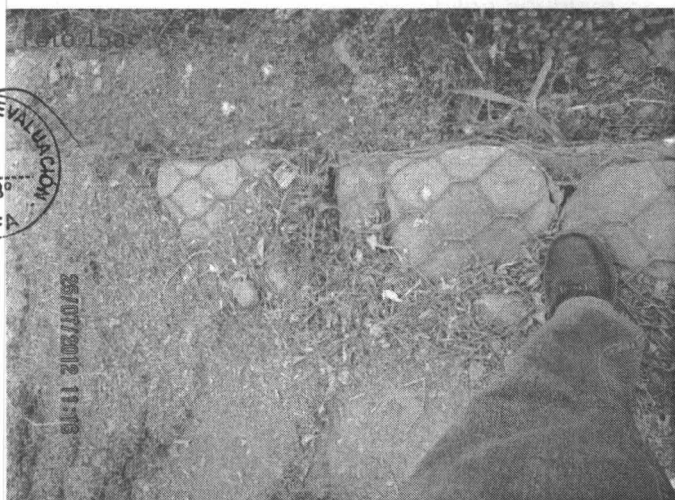
de Fotografías N° 15a y 15b. Evidencia del enmallado de los taludes de reforzamiento en el cauce del río Chillón aguas abajo y aguas arriba del punto inspeccionado en el distrito de Los Olivos, Coordenadas UTM WGS 84 (18L 0273557E 8680291N)
