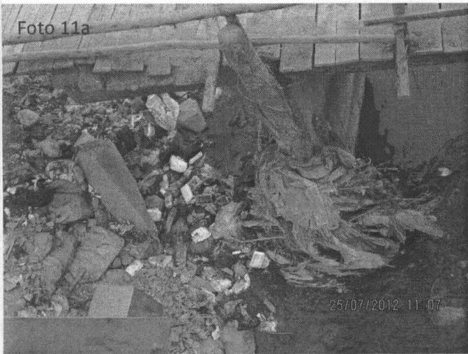
Fotografías N° 11a y 11b. Evidencia de acumulación de residuos de construcción y residuos domésticos en las partes bajas y a los costados del Puente Peatonal inspeccionado, en el distrito de Los Olivos, Coordenadas UTM WGS 84 (18L 0273826E 8681082N)
