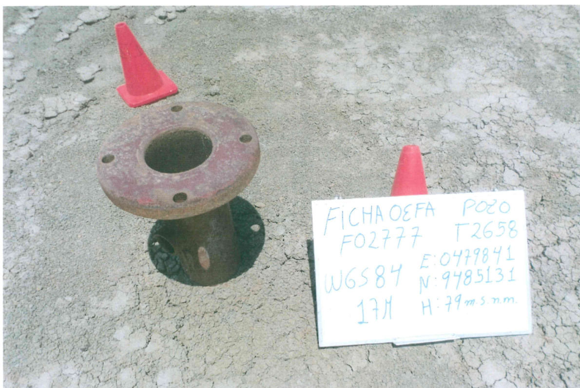
Fotografía N° 1. Pozo con código PERUPETRO T2658 y código Ficha OEFA F02777, se observa el casing corroído con dos tuberías laterales y unido a un cabezal compuesto sólo por una brida que se encuentra abierta al ambiente.
