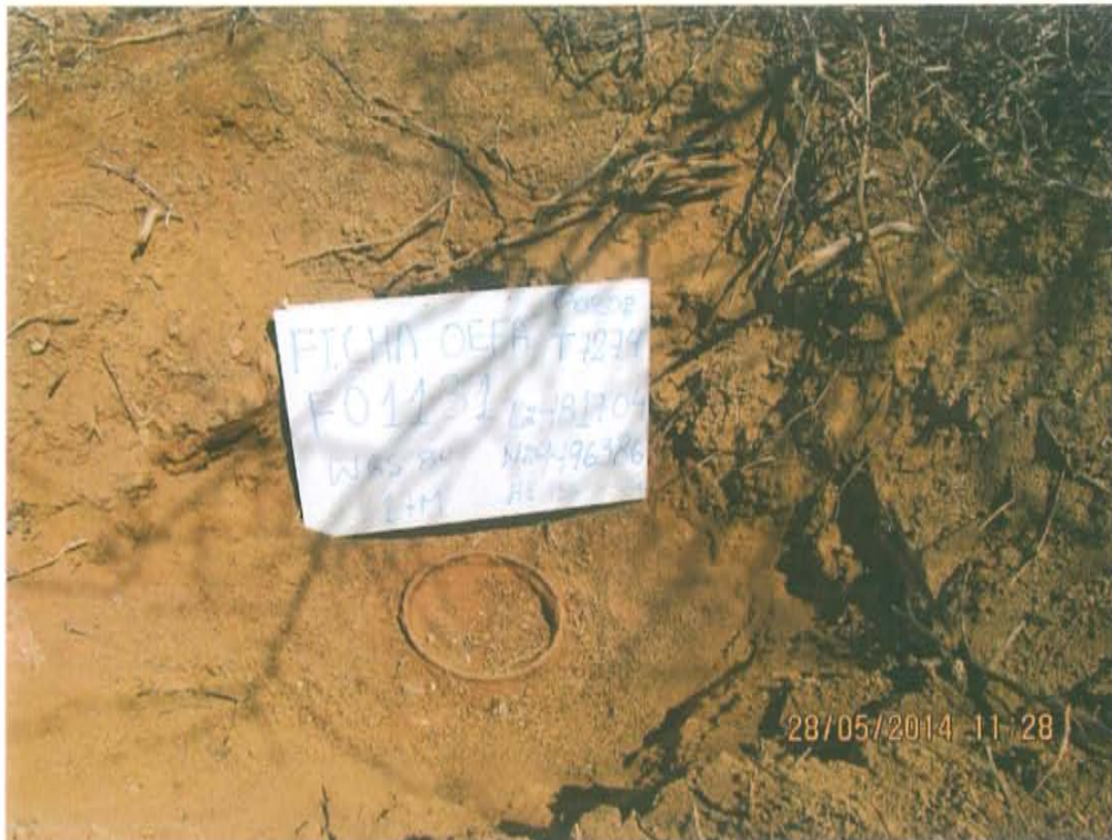
Fotografía N° 1. Se observa casing de 9,5 plg de diámetro lleno con arena a nivel del suelo en el interior de un hoyo.
