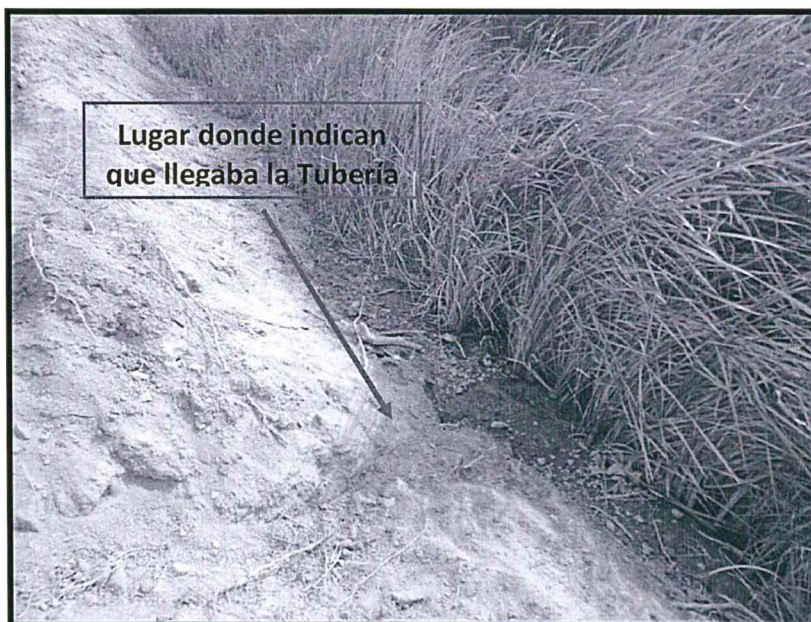
Fotografía N° 06. Canal de drenaje donde posiblemente llegaba la Tubería
