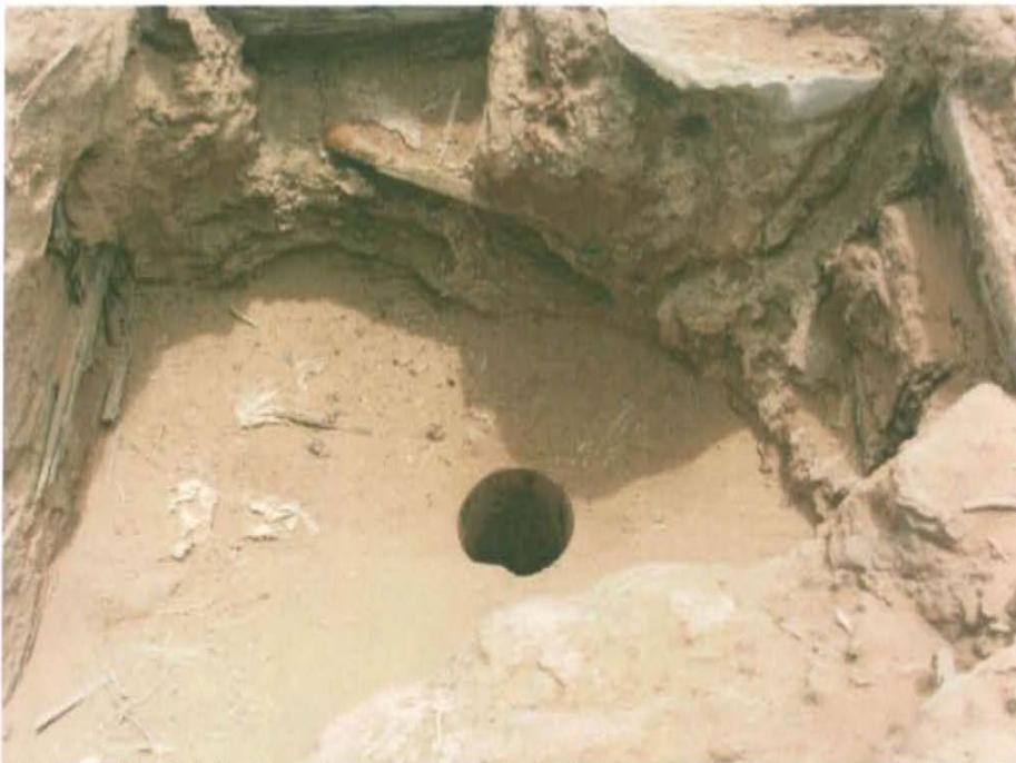
Fotografía N° 2. Se observa pozo inactivo que presenta una casing, el cual se encuentra abierto, sin elemento de cierre tales como válvulas, llaves entre otros, que garantizan un cierre hermético del pozo, tampoco se ha rellenado la cantina deteriorada.
