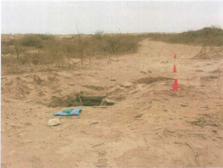
Fotografía N° 1. Ubicación del pozo inactivo ubicado en un terreno plano ondulado, se aprecia la cantina deteriorada.
