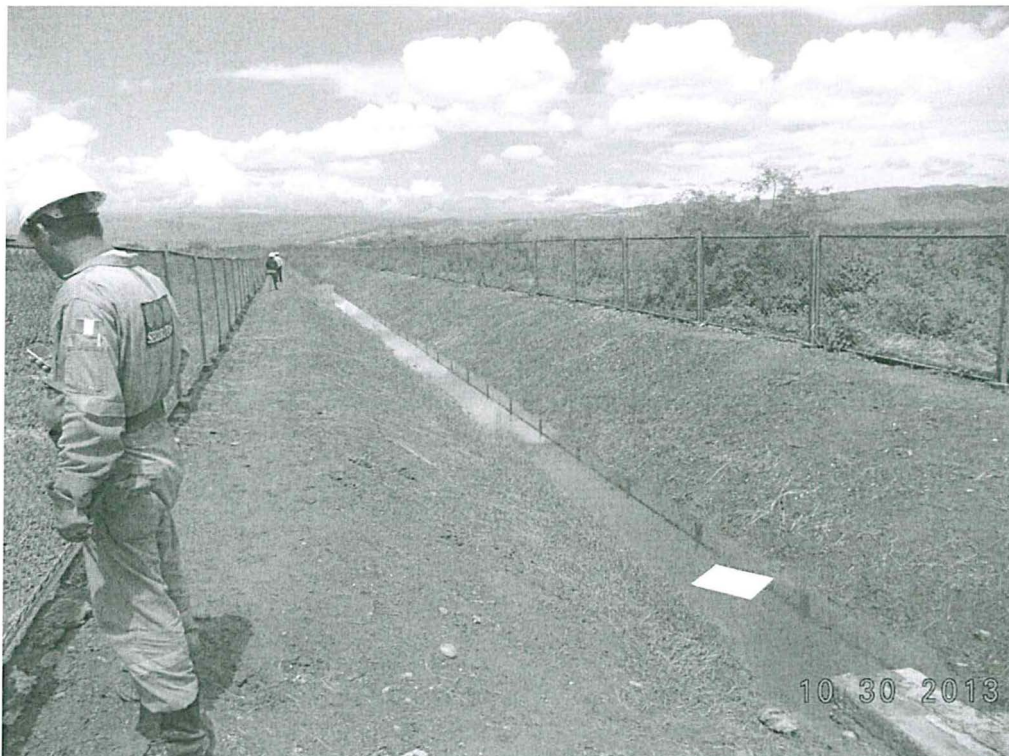
Fotografía N° 4: Canal por donde recorre el efluente que sale de la poza de oxidación
